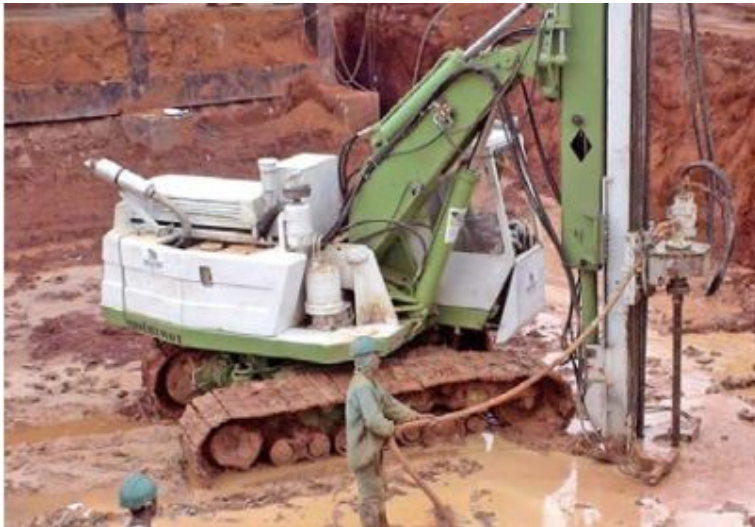
Estacas para reforço do solo na região dos viadutos da EPTG - Brasília/DF Execução de 23.310m de estacas do tipo Alluvial Anker.
