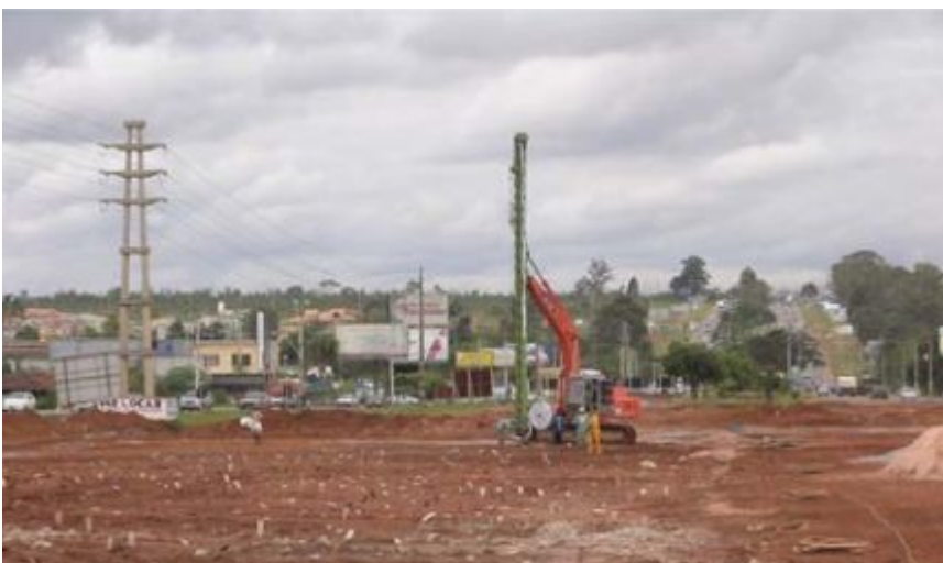
Tratamento de solos moles com cravação de Geodrenos - Brasília/DF Cravação de 30.824 m de geodrenos na região dos viadutos da EPTG.
