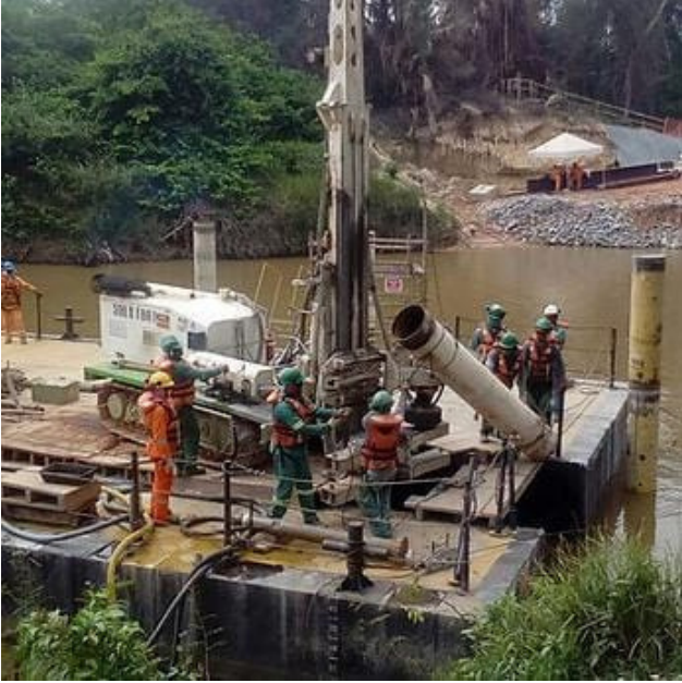
Execução de 75 estacas raiz embarcada, para a ampliação da EFC - Marabá/PA
