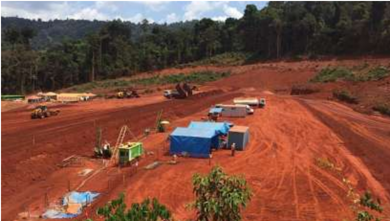
Injeções de consolidação em rocha para fundação de dique de captação - Parauapebas/PA
