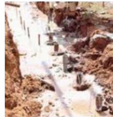
Estacas para reforço do solo na região dos viadutos da EPTG - Brasília/DF Execução de 23.310m de estacas do tipo Alluvial Anker.
