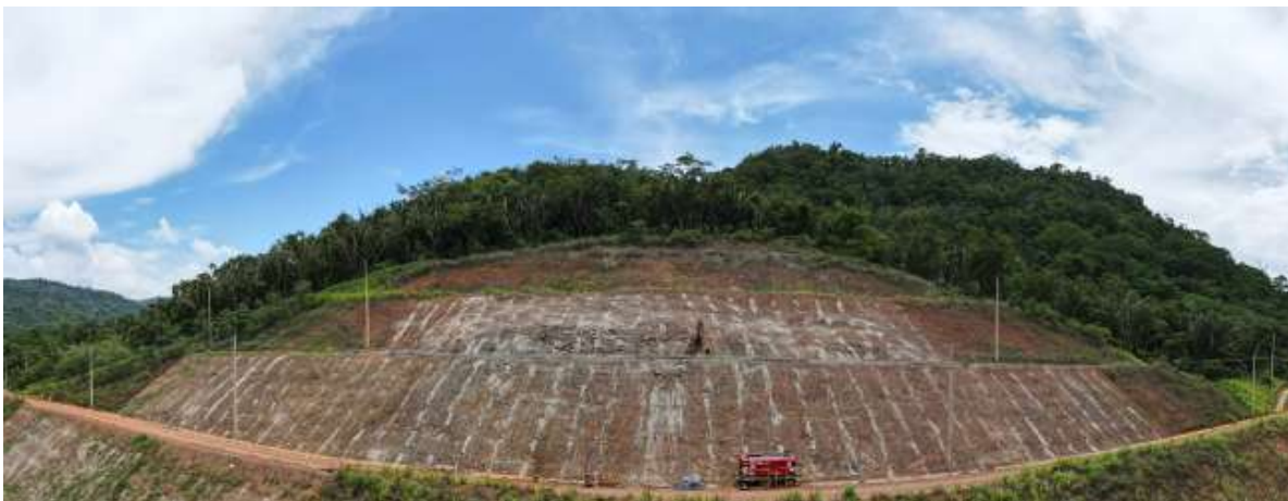
Recuperação de taludes rochosos lindeiros à ferrovia EFC por meio de solo grampeado e tela metálica Steelgrid - Canaã dos Carajás/PA
