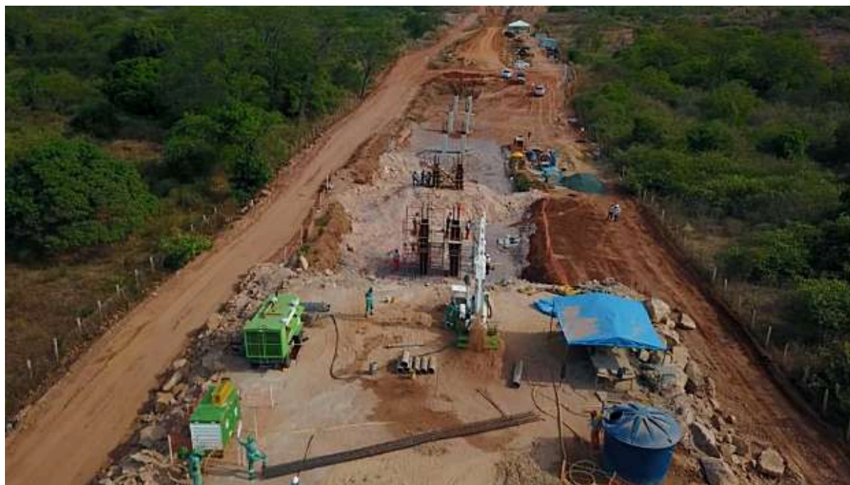
Fundação de viaduto sobre a ferrovia Transnordestina em estacas raiz - Simplicio Mendes/PI
